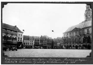
Oude gevel Markt voor doorbraak brug
