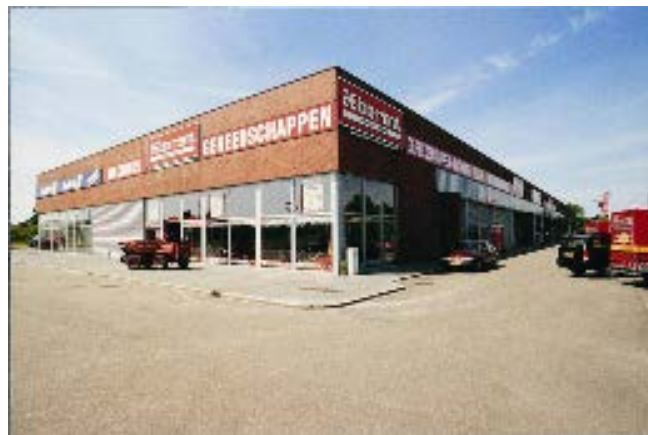
Een simpel bedrijfsgebouw met een overdaad aan illegaal aangebrachte uitingen van reclame die niet aan de criteria voldoen. Bosscherweg 252, Maastricht.
